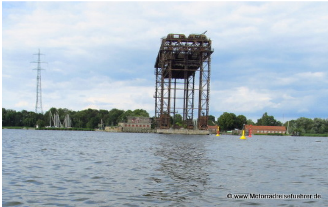
Eisenbahn-Hubbrücke Karnin (Usedom)
